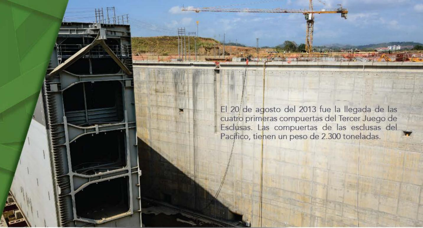
El 20 de agosto del 2013 fue la llegada de las cuatro primeras compuertas del Tercer Juego de Esclusas. Las compuertas de las esclusas del Pacífico, tienen un peso de 2.300 toneladas.
